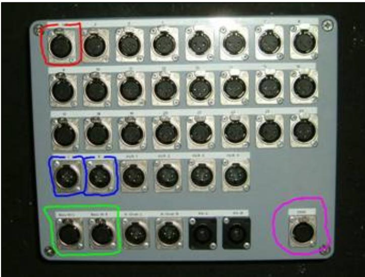
Der Kasten befindet sich (von der Aula aus gesehen) rechts an der Bühnenwand, unter den Sicherungen. **Mischpult hinten in der Aula: In der Regel werden nur die ersten drei Reihen benutzt. Dort werden die Stecker für die Instrumente und Mikrophone eingesteckt.**
